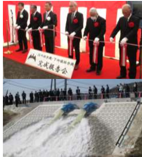
ぬまがわ 沼川排水機・下御領排水機 完成報告会
