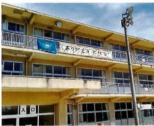
建て替えられる西小学校北校舎
